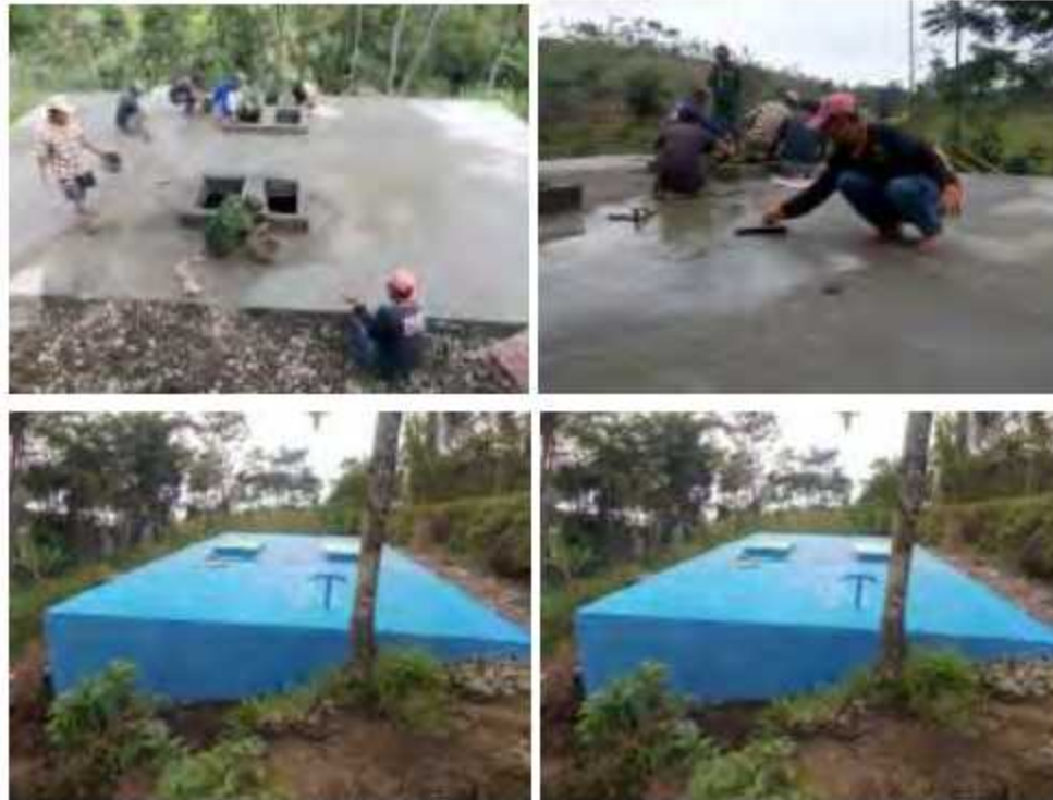
Gambar 16. Pemelesteran dan pengecatan bak pengolahan air bersih
