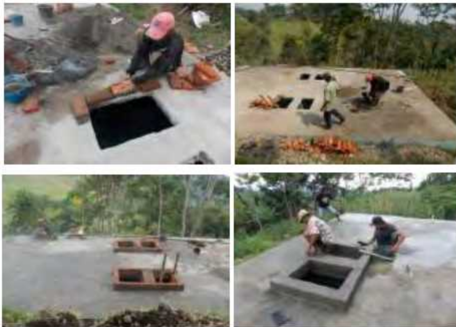
Gambar 15. Pembuatan pintu kontrol
