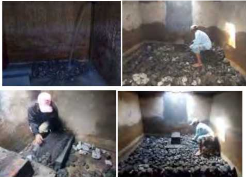
Gambar 14. Pemasangan filter bak pengolahan air bersih
