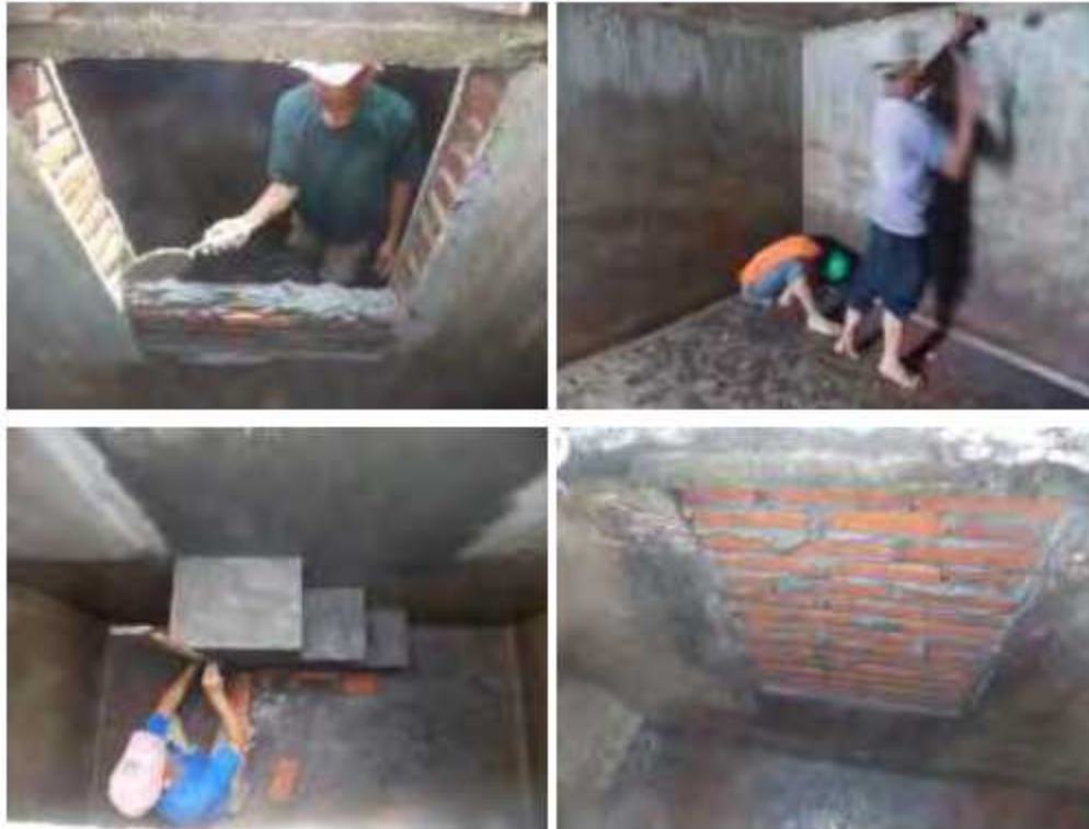
Gambar 13. Penyekatan bak pengolahan air bersih
