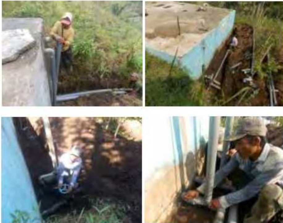
Gambar 17. Pengantian dan penyambungan pipa distribusi
