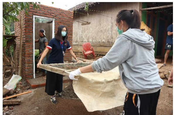
Gambar 8 Peserta COP Membantu Mengayak Pasir untuk Bahan Pembangunan Toilet
