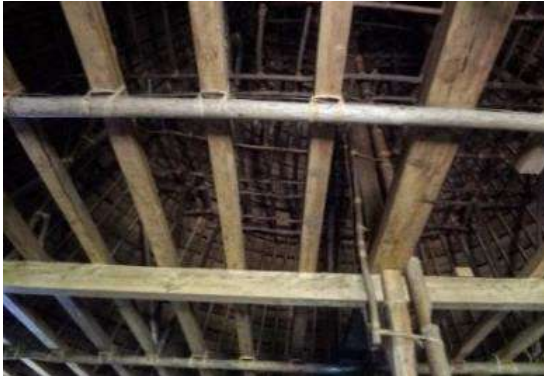
Gambar 3. Konstruksi ikat dalam pembuatan balok lantai
