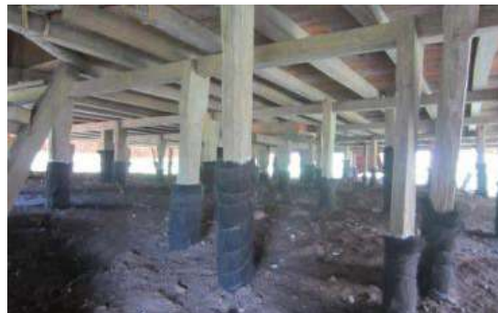
Gambar 6. Sistem Konstruksi dengan Pahatan pada Hiri Ngaung
