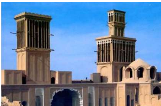
Gambar 7. Penerapan prinsip wind tunnel pada bangunan Aghazadeh Mansion di Abarkuh city, Yazd, Iran Sumber: Dehghani-sanij, 2014
